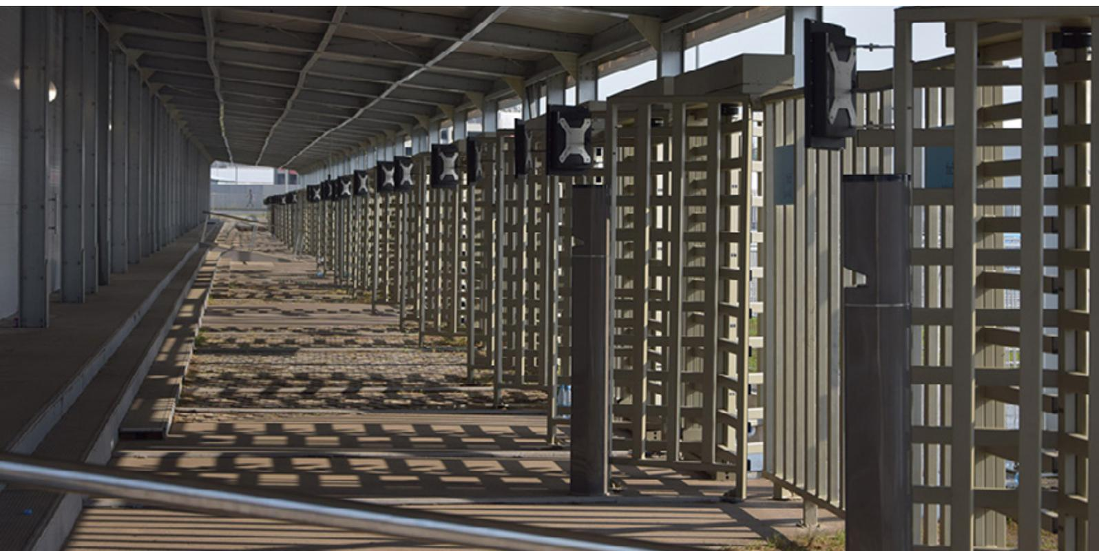
Для быстрого освобождения прохода при экстренной ситуации или пропадании электропитания предусмотрена возможность автоматической разблокировки ротора турникета.
